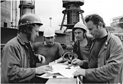
Ungarische Monteure auf der Baustelle eines Zementwerks in Deuna, 5. August 1974. (© Bundesarchiv, Bild 183-N0806-0009, Foto: Jürgen Ludwig)
